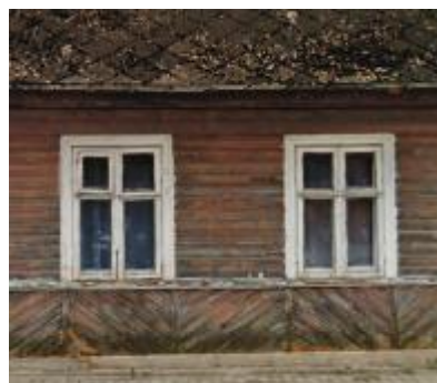
Il. 4 Ozdobny szalunek domu mieszkalnego na ul. Kamedulskiej
