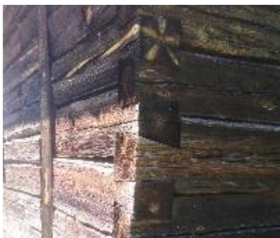
Il. 3 Konstrukcja sumikowo-łątkowa i na rybi ogon. Bania ruska w Budzie Ruskiej
